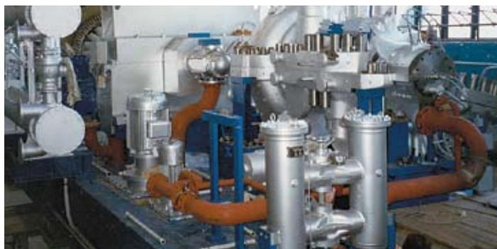
**Ческе-Будеевице, Чешская Республика:** Турбина с противодавлением мощностью 29 МВт производит пар для централизованного теплоснабжения
