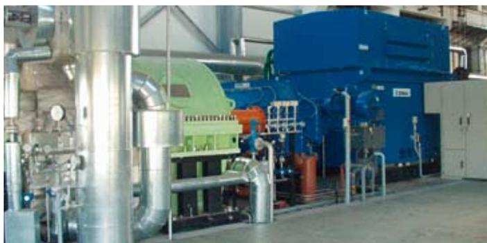
**Мелец, Польша:** Конденсационная турбоустановка мощностью 21 МВт с отбором пара на пылеугольной теплоцентрали польской энергокомпании ТЭЦ Мелец
